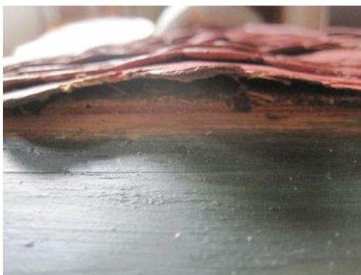
A tető papundekli borításának állapota kezelés előtt és után
