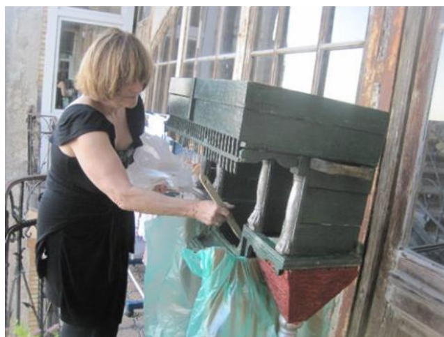
Szilárdítás ecseteléssel
