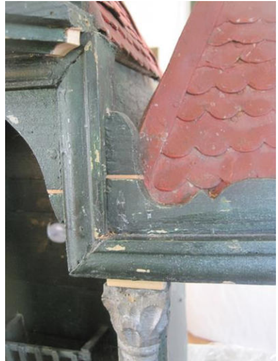
Profillécek kiegészítése, réskitöltés és elveszett elem pótlása
