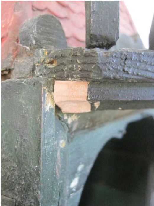
Profillécek kiegészítése, réskitöltés és elveszett elem pótlása
