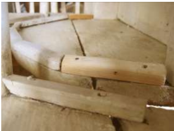
A profillécek és a kerítéslécecskék pótlásai.
