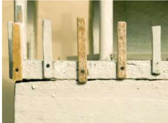
A profillécek és a kerítéslécecskék pótlásai.
