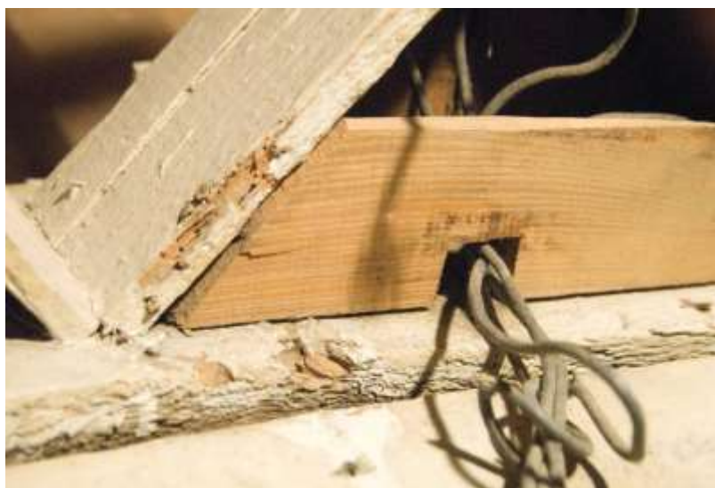
Rovarkárosodott faanyag.
