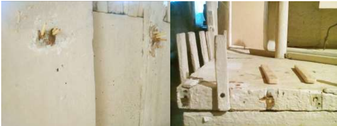
A fül alatti és a lécecskék szöghelyeinek kitöltése.
