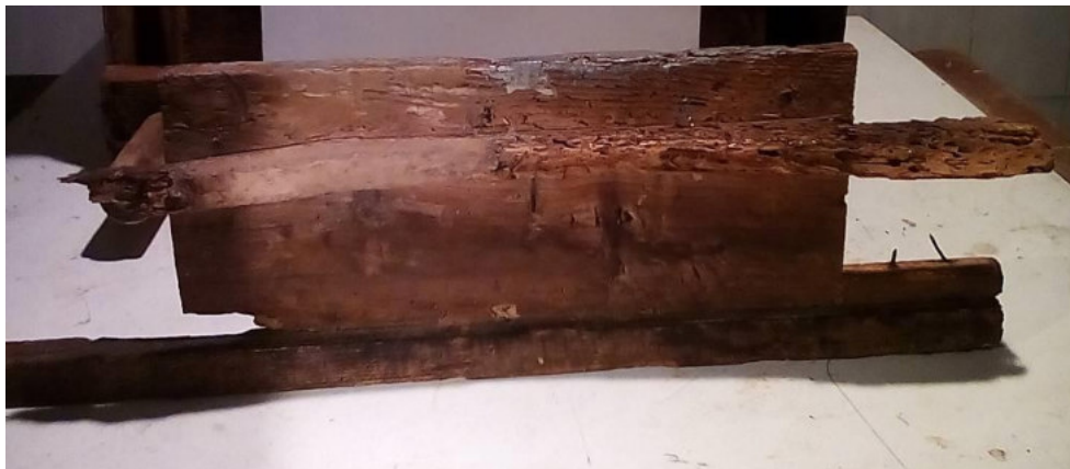
A bábmozgató folyosó a homloklap hátoldalához kapcsolódó, rovarkárosodott elemének szilárdítása és tömítése
