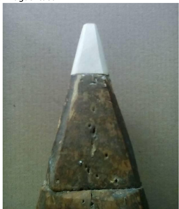
A középső torony sisakjának lefűrészelt, illetve letört vége és annak kiegészítése
