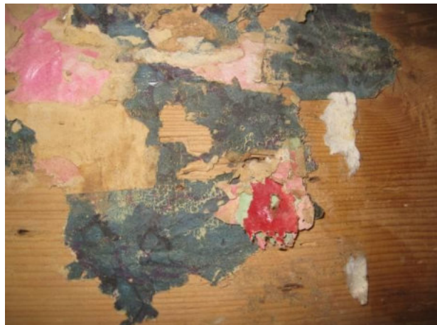
A betlehem belsőoldalfalán feltárt papírok
