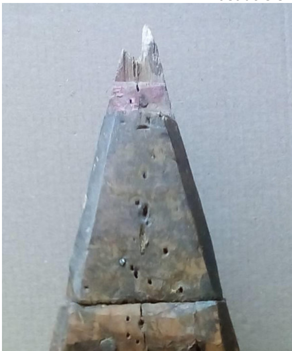
A középső torony sisakjának lefűrészelt, illetve letört vége és annak kiegészítése
